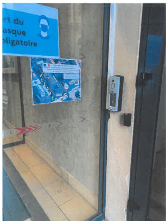
Interphone entrée bâtiment Erignac (Bâtiment A)
