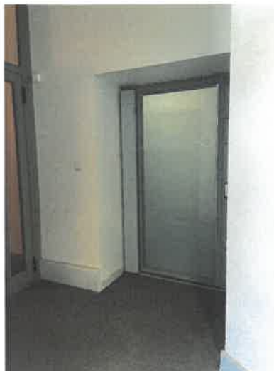
Après le sas de sécurité directement sur la gauche accès ascenseurPMR limité à 250KG maxium
